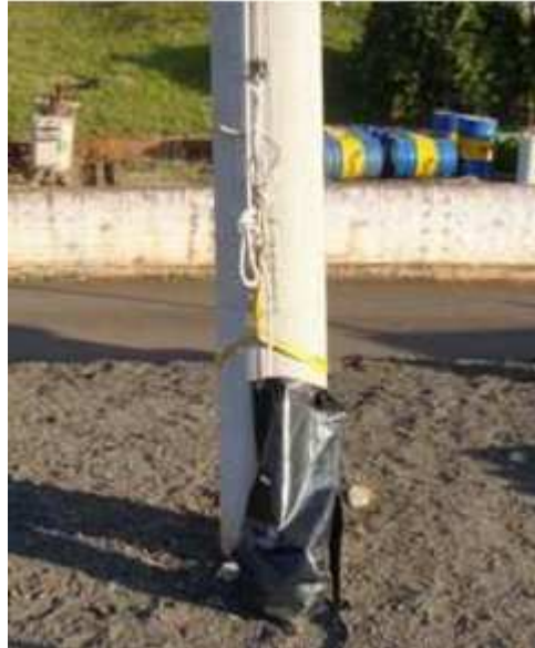
Figura 27 - Instalação do trava-quedas na parte da linha de vida do nó 8 duplo
