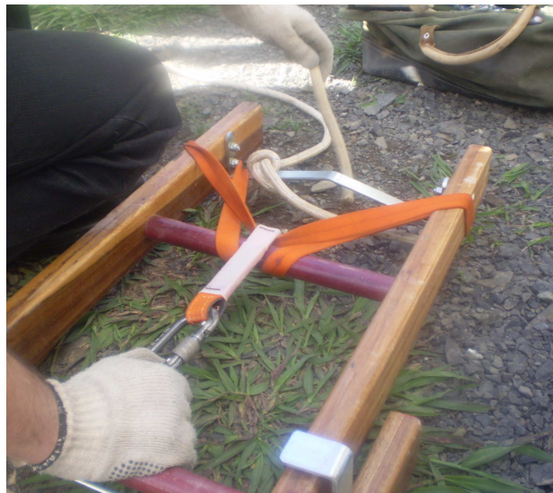
Figura 11 - Instalação do ponto de ancoragem
