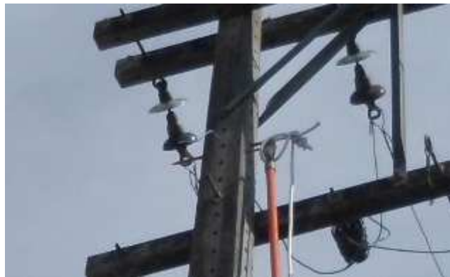
Figura 26 - Instalação do agulhão no poste
