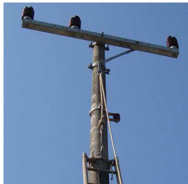
Figura 16 - Ancoragem na ferragem do poste
