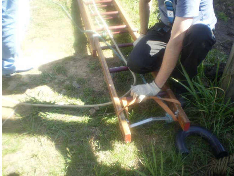
Figura 12 - Instalação da linha de vida
