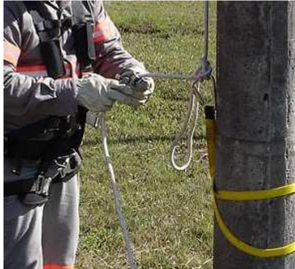
Figura 34 - Instalação do trava-quadras
