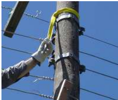
Figura 15 - Ancoragem com fita e mosquetão no poste
