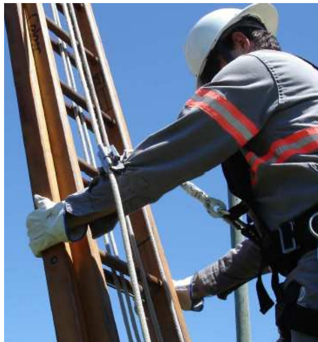
Figura 32 - Instalação do talabarte
